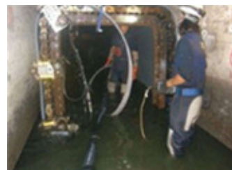
更生工法による再整備
