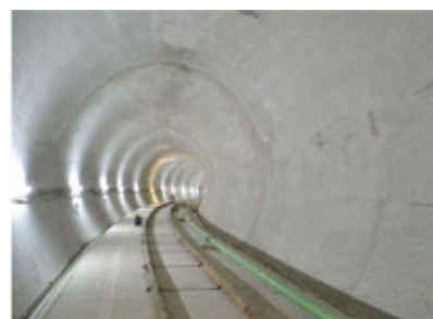
大師河原貯留管の整備
