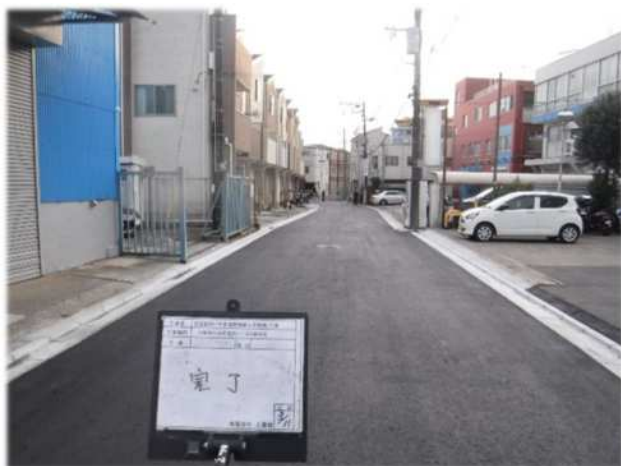
道路補修工事（施工後）
