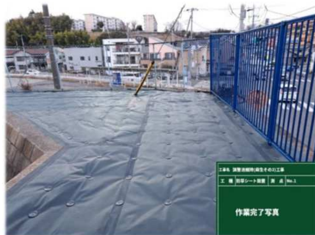
調整池維持工事（施工後）
