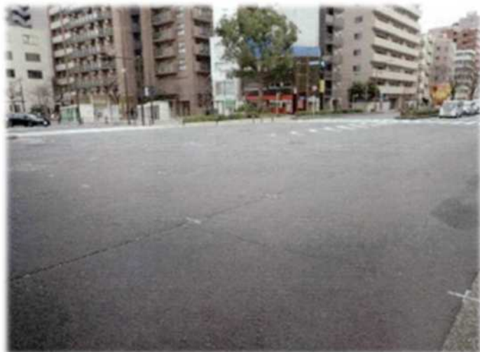
工事着手前の様子
