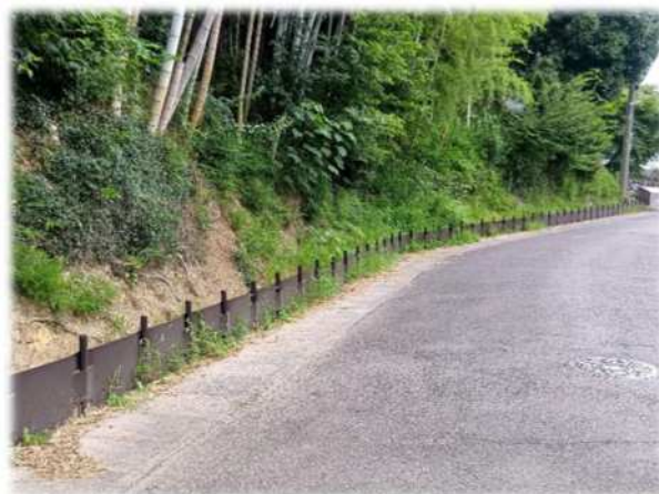
土留め設置後
