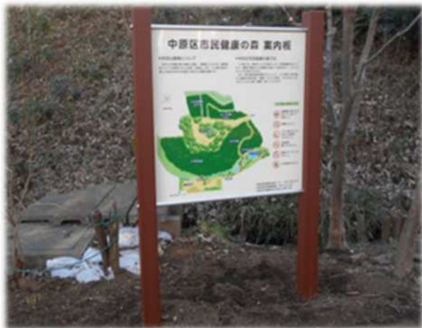
案内板補修工事の実施後
