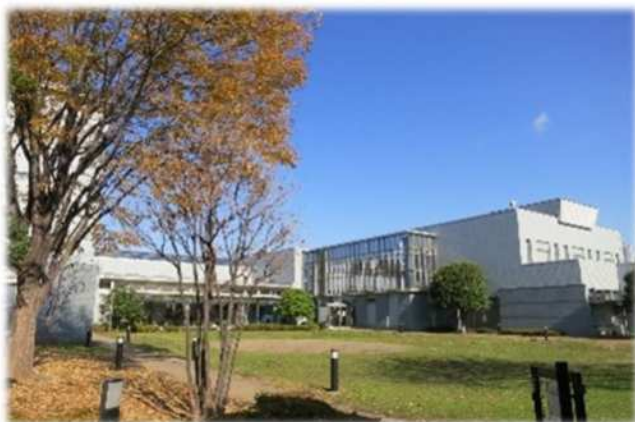
国際交流センター（施設外観）
