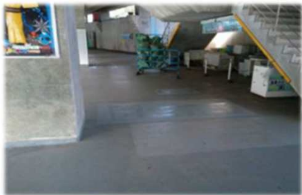
等々力陸上競技場バックスタンド (コンコース床補修工事実施後)
