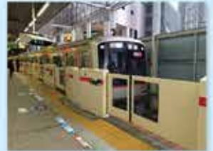
東急東横線武蔵小杉駅のホームドア
