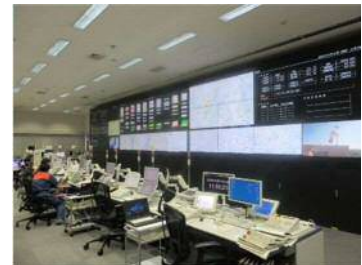
消防指令センター
