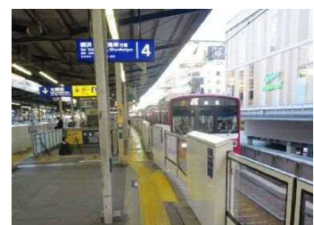
ホームドア設置例 (京急川崎駅)
