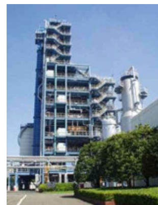
使用済みプラスチックから水素等を製造するプラント(昭和電工川崎事業所)
