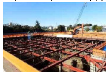
脱窒ろ過池工事
