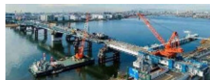
羽田連絡道路 工事施工状況
