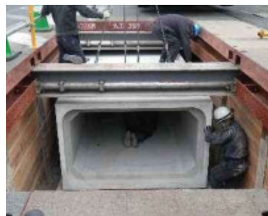
雨水管布設工事
