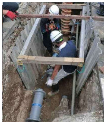
耐震管布設工事
