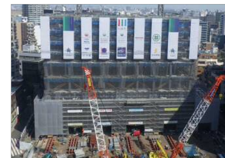
▲建設工事写真
