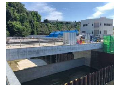
▲建設工事写真（分流部）
