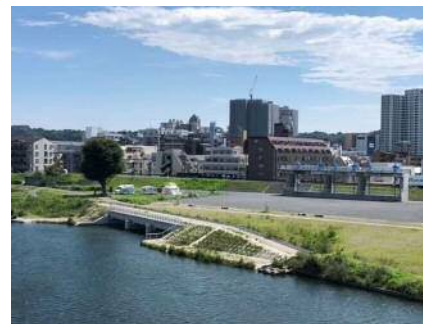
▲建設工事写真（放流部）
