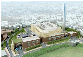
橋処理センター整備事業
