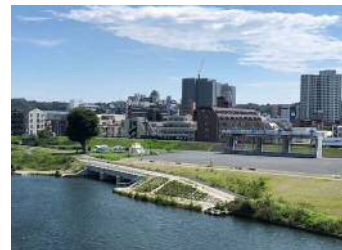
五反田川放水路整備事業
