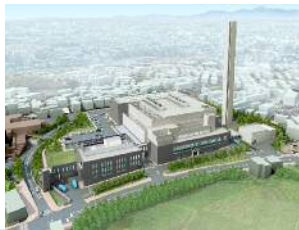
橋処理センター整備事業
