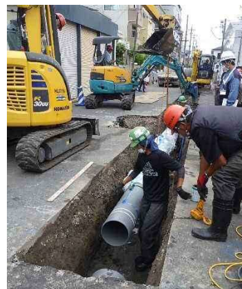
耐震管布設工事
