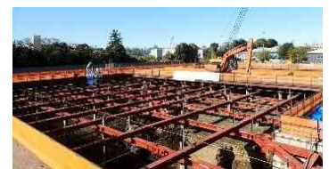
脱窒ろ過池工事
