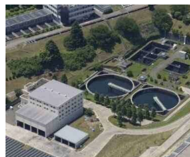
長沢浄水場排水処理施設
