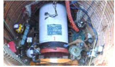
雨水管布設（推進工法）
