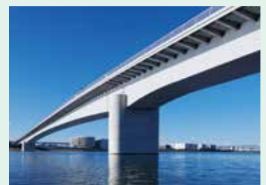
多摩川スカイブリッジ
