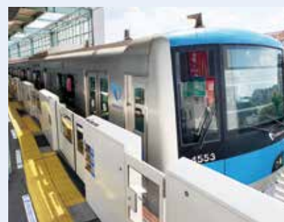
ホームドア設置例(小田急登戸駅)
