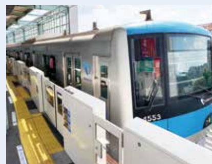
ホームドア設置例(小田急登戸駅)
