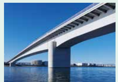
多摩川スカイブリッジ
