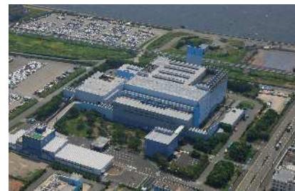
浮島処理センター
