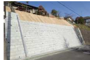
助成制度を活用した 擁壁の改修例
