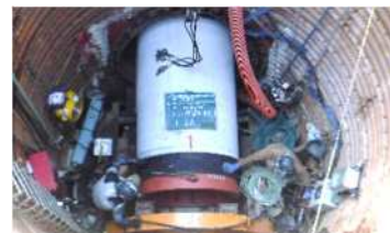
雨水管布設（推進工法）
