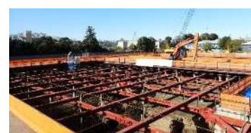
脱窒ろ過池工事
