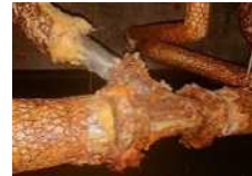
老朽化した配管
