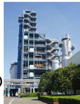
使用済みプラスチックから水素等を製造するプラント（レゾマック川崎事業所）
