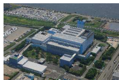
浮島処理センター
