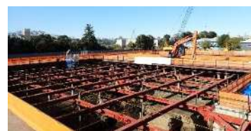
脱窒ろ過池工事
