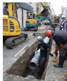
耐震管布設工事
