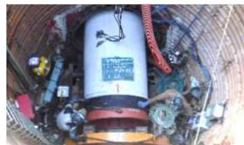
雨水管布設（推進工法）
