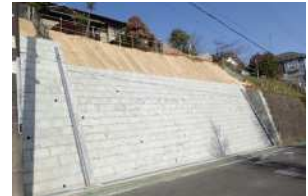
助成制度を活用した 擁壁の改修例
