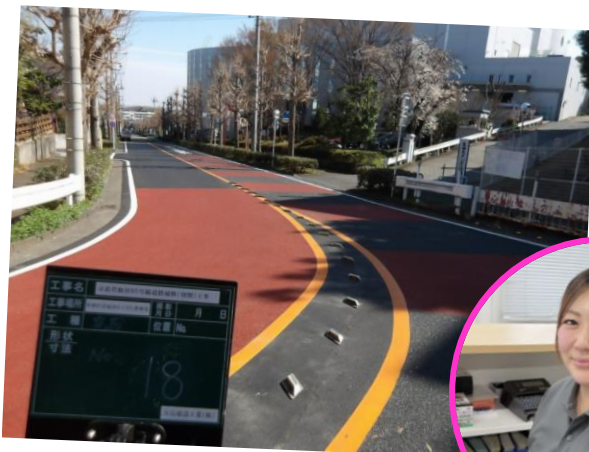
受賞対象工事 市道菅仙谷95号線道路補修 (切削) 工事
