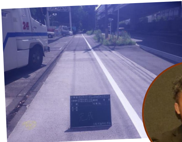
受賞対象工事 池上町200mm-100mm 配水管布設替工事
