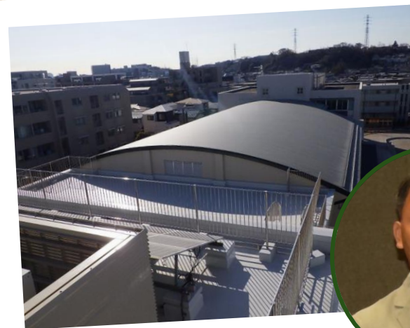
受賞対象工事 井田小学校校舎・体育館外壁 塗装改修工事
