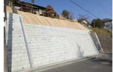
助成制度を活用した擁壁の改修例
