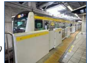
ホームドア設置例 (JR 南武線登戸駅)
