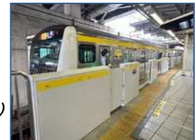
ホームドア設置例 (JR 南武線登戸駅)
