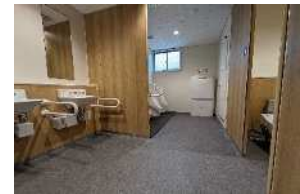
トイレ改修例(向丘出張所)
