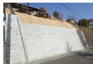
助成制度を活用した擁壁の改修例
