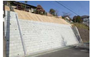
助成制度を活用した擁壁の改修例
