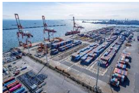
川崎港コンテナターミナル
