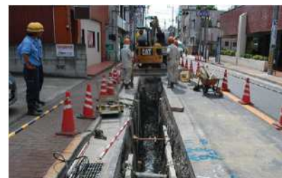
水道管路の耐震化工事
