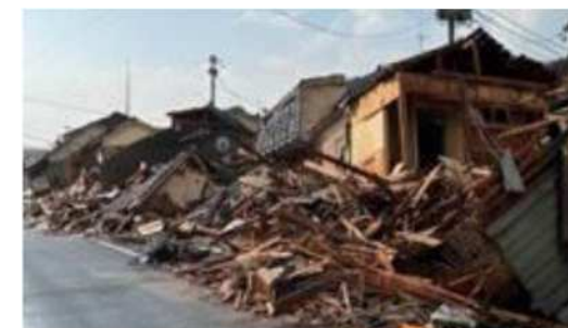
図1:令和6年能登半島地震で倒壊した建物
