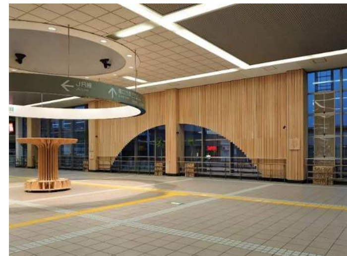
武蔵溝ノ口駅南北自由通路の木質化 (高津区)
