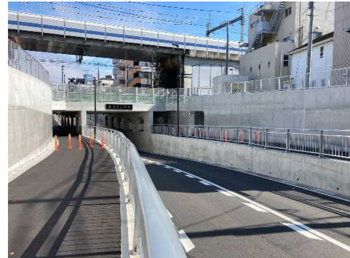
木月トンネル (中原区)
