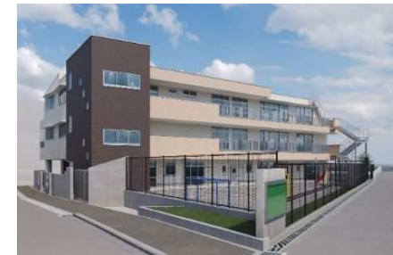
高津区保育・子育て総合支援センター（令和9年度中開設予定）
