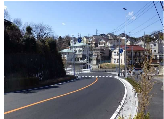
都市計画道路野川柿生線（王禅寺工区）の整備 （麻生区）
