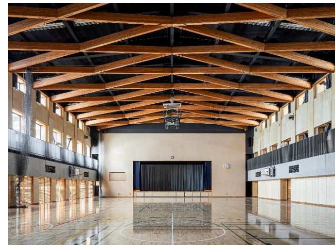
新小倉小学校施設の木質化 （幸区）
