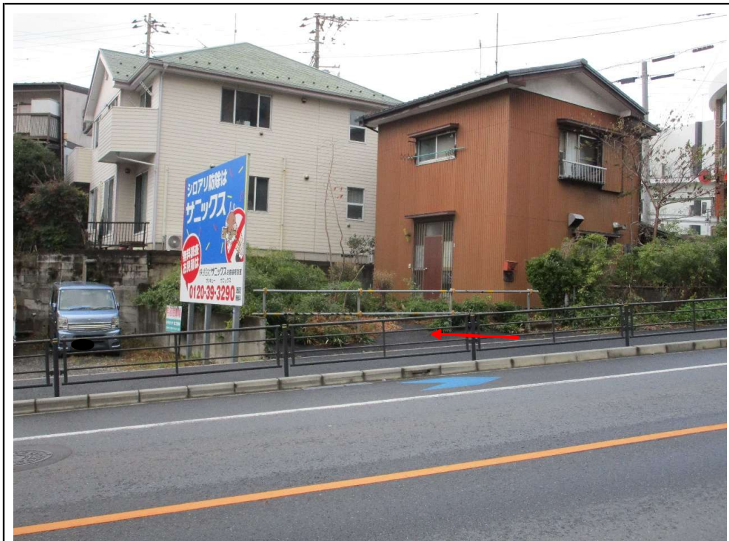
02 南西方より撮影(近景)
