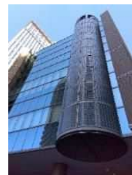
（写真⑤）外壁（西側）
