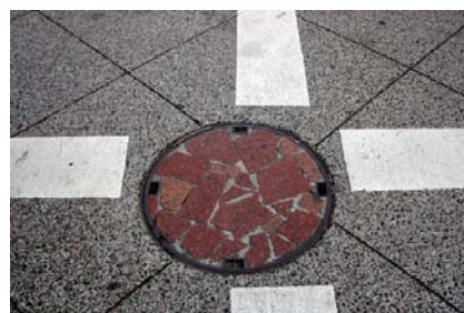
リニューアルした商店街の路面舗装には、以前の舗装材の碎石を使用（ブレーメン商店街）
