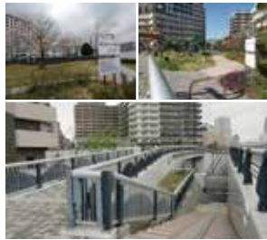
上左：西口さくら緑地 上右：西口さんかく公園 下：大宮町歩道橋
