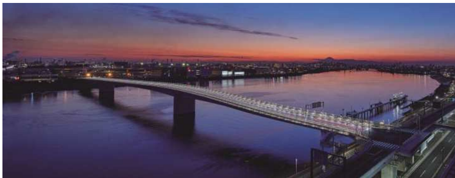
▲多摩川スカイブリッジ
