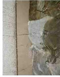
④ 鉄筋の腐食
