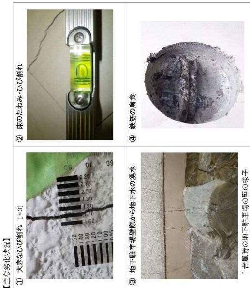
【\*3】一般的に0.3mm以上のひび割れは構造クラック(鉄筋強度に影響を及ぼす)と判定されます。
