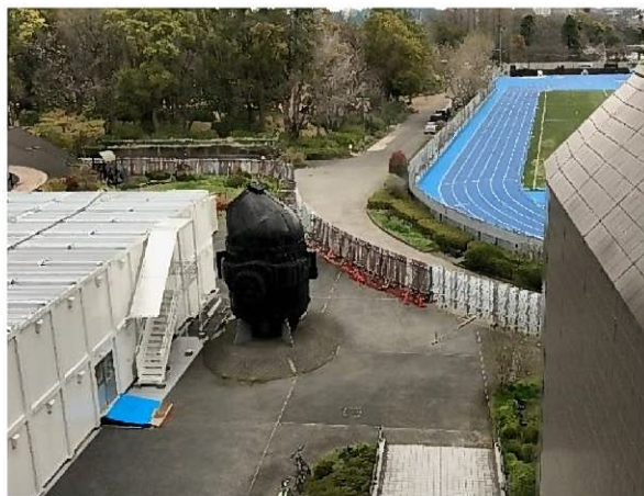
施設前広場の仮囲い（上部から撮影）
