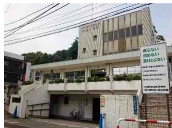
旧庁舎外観（正面）
