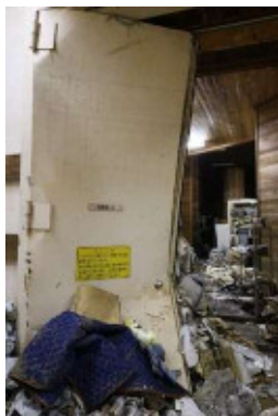
【浸水により破損した収蔵庫扉】
