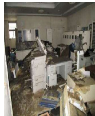
【被災後の中央監視室】
