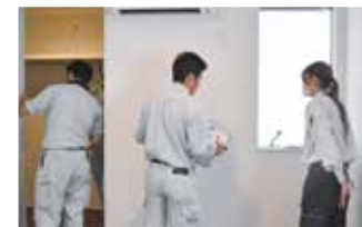
▲ 現場での社内検査の様子(工事部の女性も活躍!)
