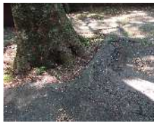
（根上がりによる通路の隆起）（池にヘドロが堆積）
