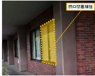
（大ホール棟の耐震補強）
