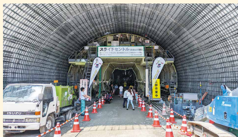
トンネルの内壁工事の様子
