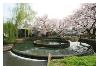
二ヶ領用水久地円筒分水
