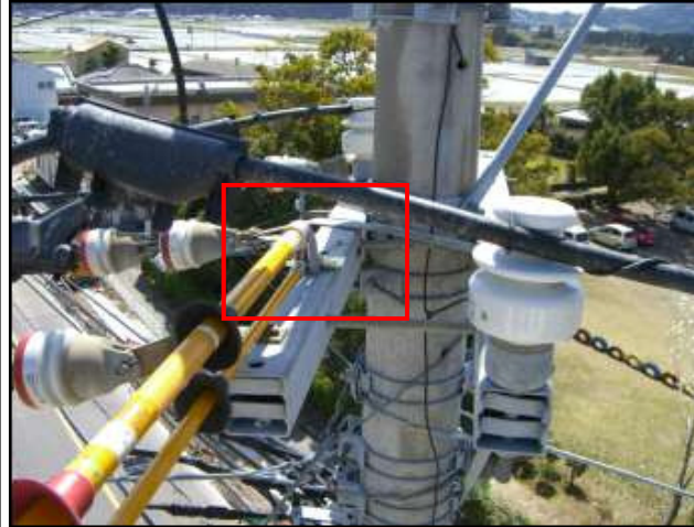
【 シール取り付け状況 】
