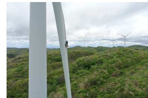
風力発電所のブレードを点検をする作業員=2021年5月11日午前、秋田県由利本荘市、ドローンで小平重隆様撮影
