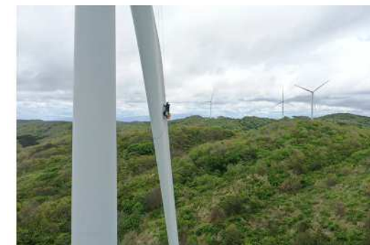
風力発電所のブレードを点検する作業員=2021年5月11日午前、秋田県由利本荘市、ドローンで小平重隆様撮影
