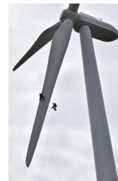
日立造船の風力発電で作業をする特殊高所技術の作業員=秋田県由利本荘市、豊野真三様撮影
