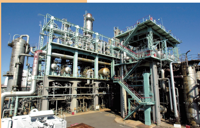
いくつもの塔やタンクがパイプでつながっているJXTG エネルギー川崎製造所のエチレン製造装置。
