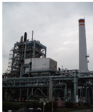
排煙脱硝設備
