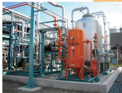
吸着式の炭化水素排出抑制設備
