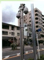
防犯カメラの設置
