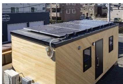
屋根の上に太陽光パネルを設置
