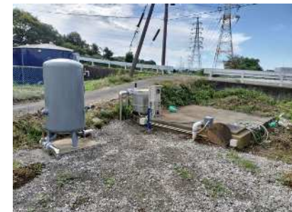
▲改修工事（井戸ポンプ）
