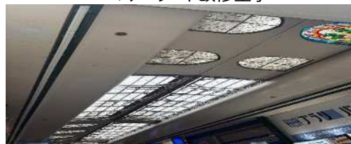
▼アーケード改修工事
