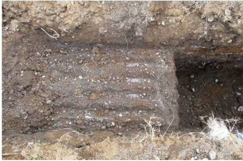
鉄板下改良土端部(西側)
