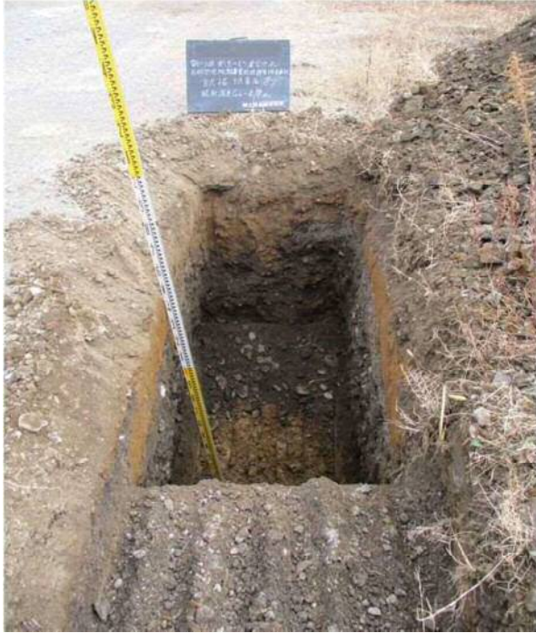
全景(東側方向) 手前は改良土
