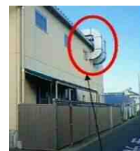
ダクト吹出口の向きを変 更し、騒音レベルを低減
