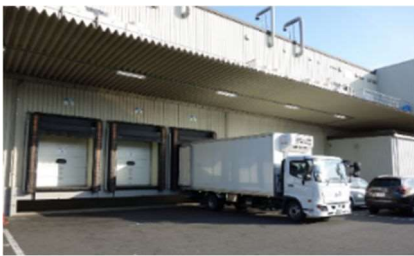
場内事業者が整備した低温管理設備
