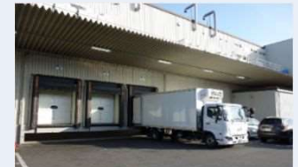
場内事業者が整備した低温管理設備
