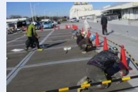
関連商品売場棟屋上防水工事
