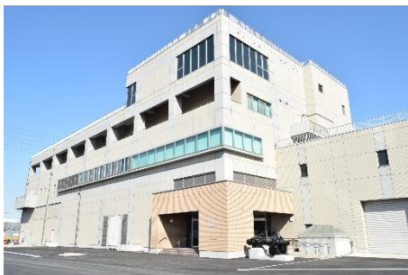
▲入江崎水処理センター
