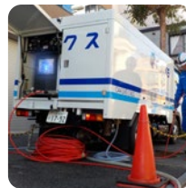
『管洗浄プラス』 施工の様子
