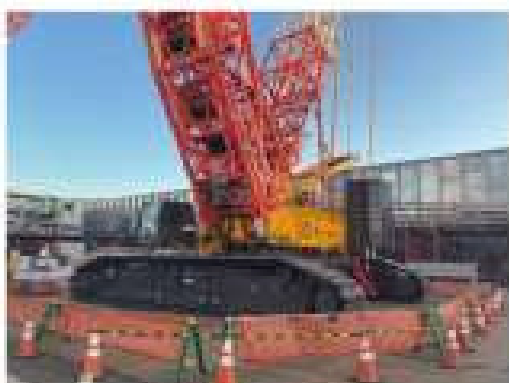
作業範囲に2重の立入禁止措置
