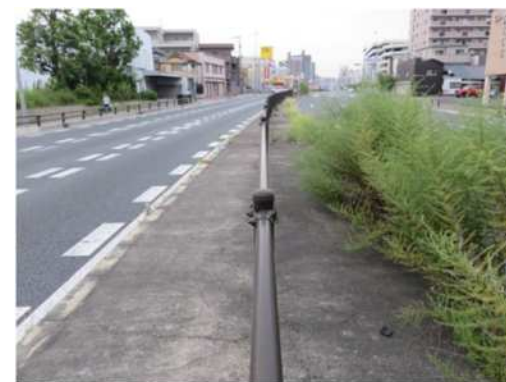
中央分離帯左側に防草ブロック(施工後7年)
