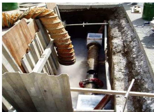
川崎市での凍結工法施工状況
